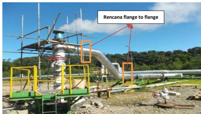
Gambar 1. Kondisi Sumur PPL-07 dan Rencana Pemasangan Koneksi Flange to Flange
